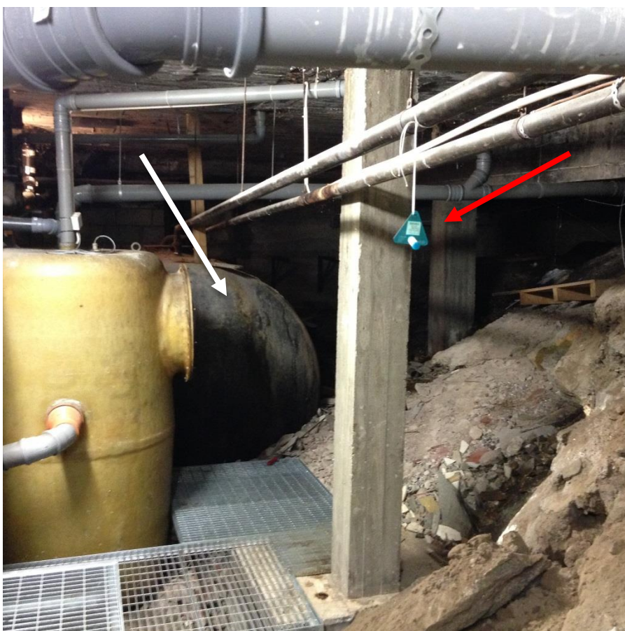
Figur 3. Provtagare i krypgrunden under fd kemtvätt, röd pil. I bakgrunden ans oljecisternen, vit pil.
